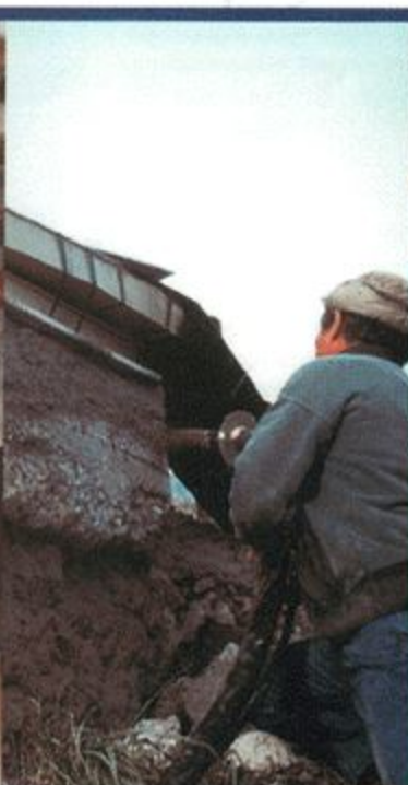
去除已遭破坏的混凝土结构中的洞落物。
